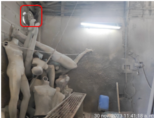
Fotografía 5. Área de pintura y extractor
